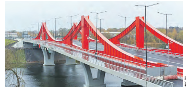
Завершаются работы по строительству нового моста через Москву-реку в районе улицы Мясищева
