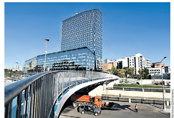
Велопешеходный мост, ведущий к научно-образовательному комплексу «Квантум парк» МГТУ имени Н. Э. Баумана, получил награду в этом году
